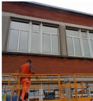
Réparation des façades en cours
