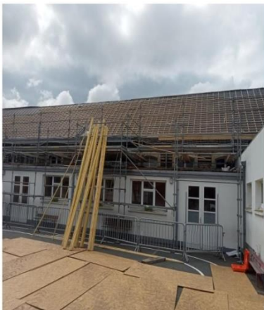
Travaux en cours
