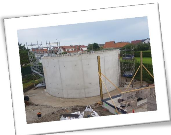
Travaux station de Sangatte 2019-2021
