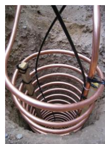
Figure 26. Capteurs horizontaux (BRGM) et échangeurs compacts (AFPG)
